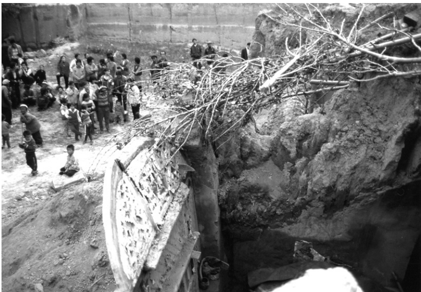
图：往年 8 月下旬几乎不下雨，可这一年淫雨不断，造成土窑洞倒塌。 (阳高县，1995 年 10 月)
