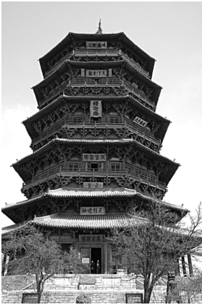
◎应县木塔是世界上最大规模的木结构建筑，塔高67米。
