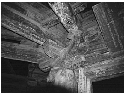
◎全部由木构件建成，没有使用铁件。
